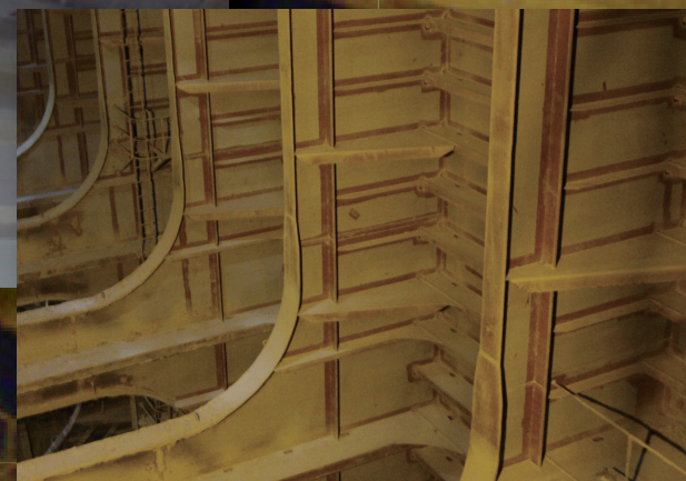
明色化により作業者の安全性が向上
