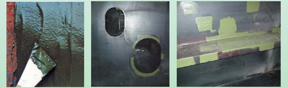
ニューフォルテバリアーは膜厚が厚いためケレン後の段差も容易に隠蔽できます。
